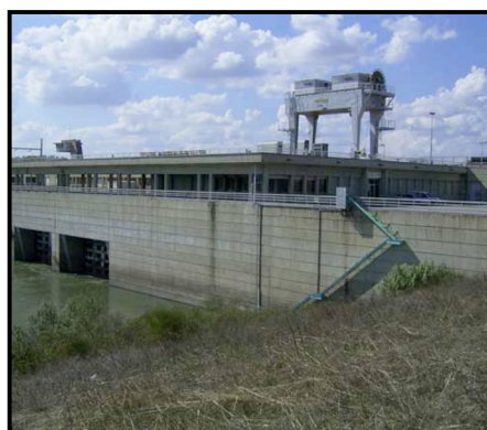
Figures 19 et 20: Passes-pièges situées en rive gauche (19) et rive droite (20) de l'usine éclusée de Beaucaire (MRM)
