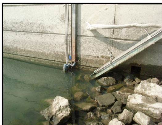
Figure 23 : Pompe hydraulique et rampe hors de l'eau en rive gauche (MRM)
